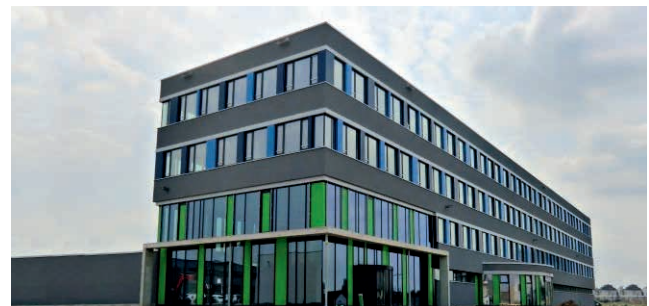
EAD Verwaltungsgebäude am eigenen Betriebshof
